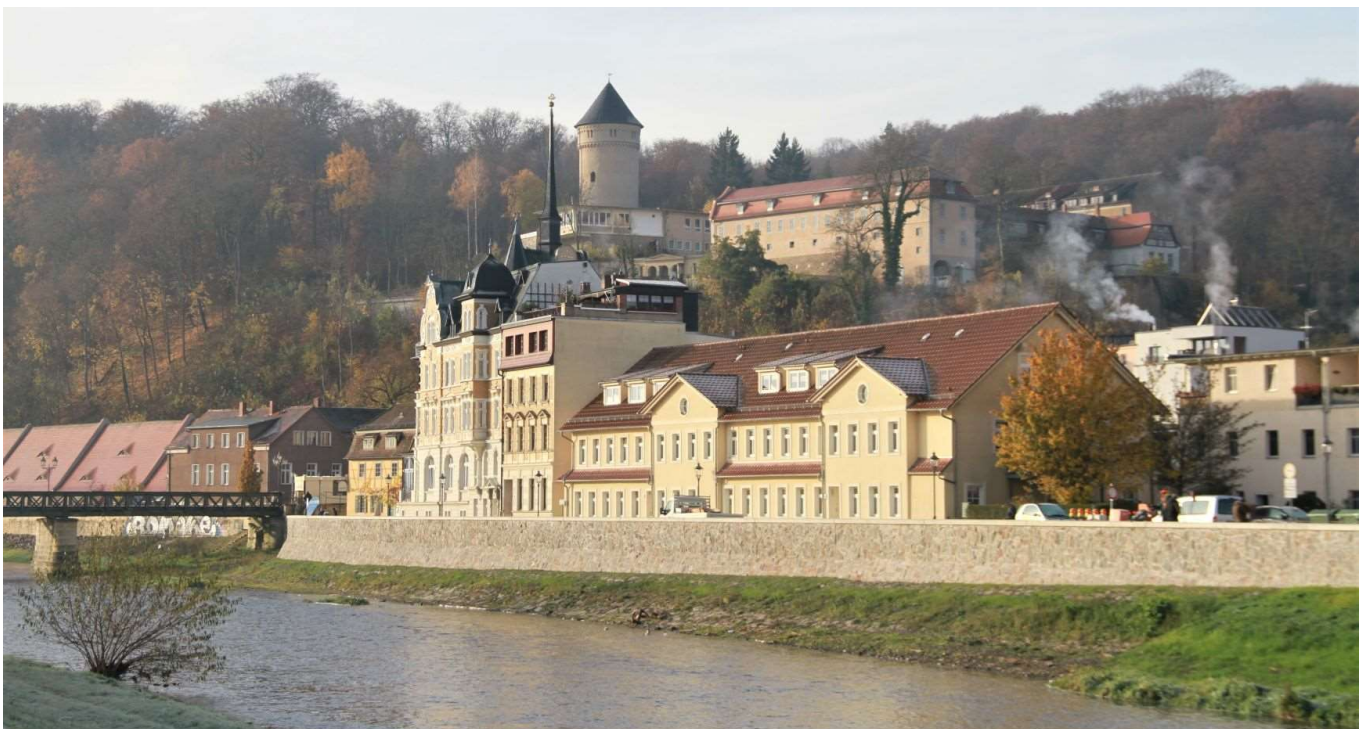
Die neue Hochwasserschutzmauer in Gera-Untermhaus. Foto: SV/Antje Stahn
