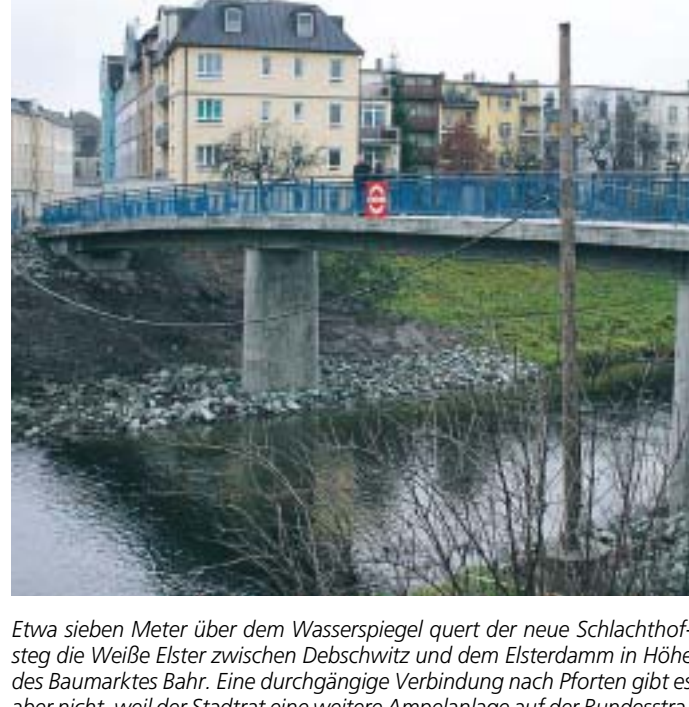
Etwa sieben Meter über dem Wasserspiegel quert der neue Schlachthofsteg die Weiße Elster zwischen Debschwitz und dem Elsterdamm in Höhe des Baumarktes Bahr. Eine durchgängige Verbindung nach Pforten gibt es aber nicht, weil der Stadtrat eine weitere Ampelanlage auf der Bundesstraße verwehrt. (Foto: KA/Eigenrauch)
